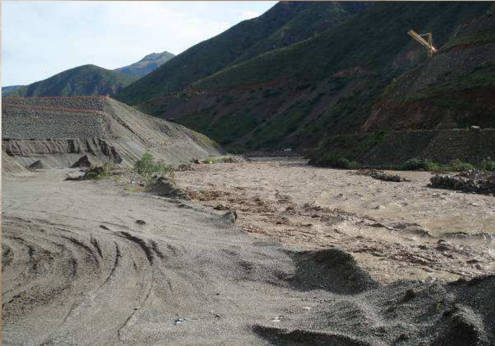
SOCAVACIÓN DE PLATAFORMA DE ACOPIO DE AGREGADOS
