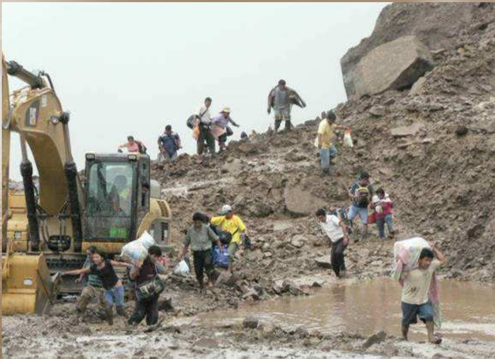
KM 44. PASE DE PERSONAS DURANTE LA RECUPERACIÓN DE LA CARRETERA
