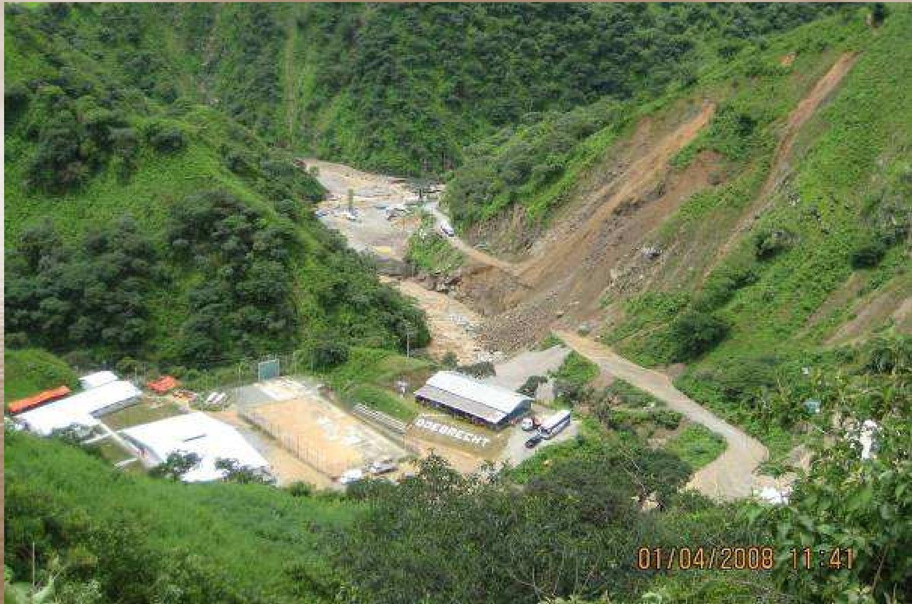
DESLIZAMIENTO E INUNDACIÓN EN CAMPAMENTO OCCIDENTE
