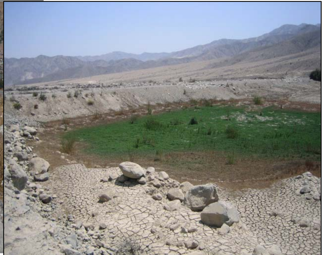
Diques de regulación caudales – Reducción de flujos de lodo
