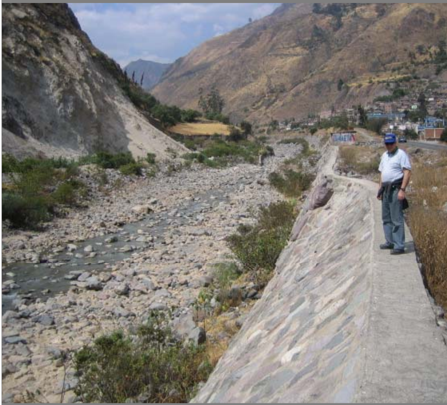
Estructura de protección frente a probables desbordes/inundaciones
