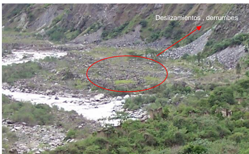
Vista de la zona del Botadero, area vulnerable propensa a peligros
