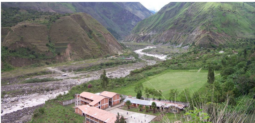
Vista de la Institución Educativa Primaria, la cual sera reubicada por estar en zona de riesgo.
